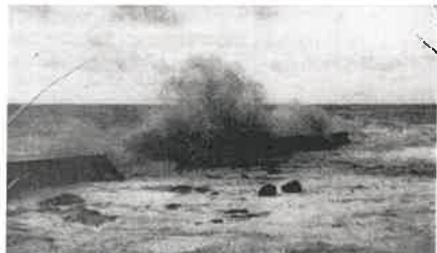
Figure 16 – Coup de mer sur la digue de Batz-sur-Mer le 14 mars 1937 (Ouest Éclair)
