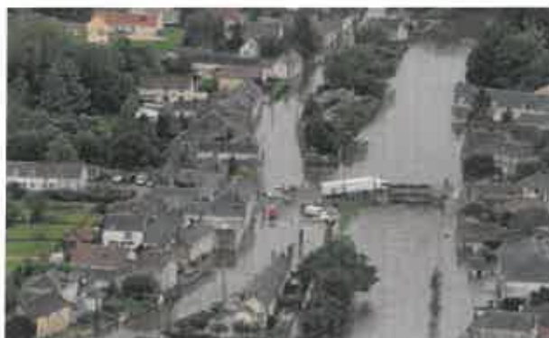
Figure 11 - Débordement du canal d'Orléans à Fay-aux-Loges (source SIBCCA)
