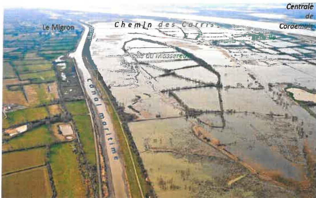
Figure 14 – Photo de l'estuaire de la Loire rive gauche lors de la submersion de février 2010 (GIP Loire-Estuaire)
